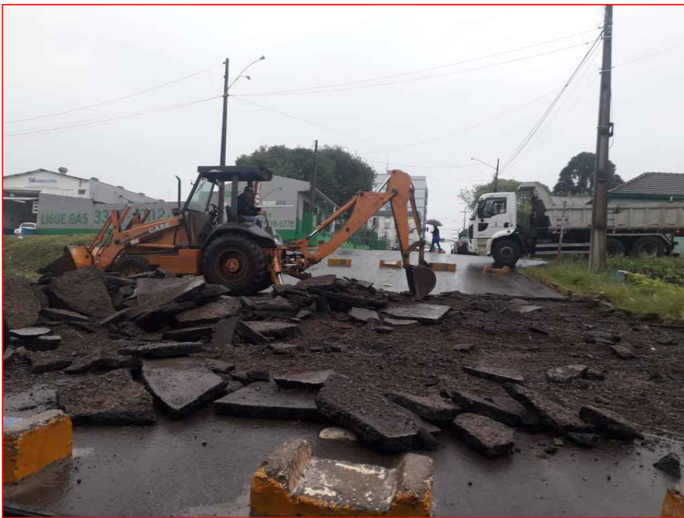
Demolição de Pavimentação Asfáltica
