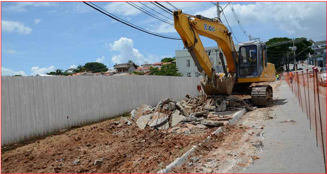
Remoção de Pavimento Intertravado "Paver"
